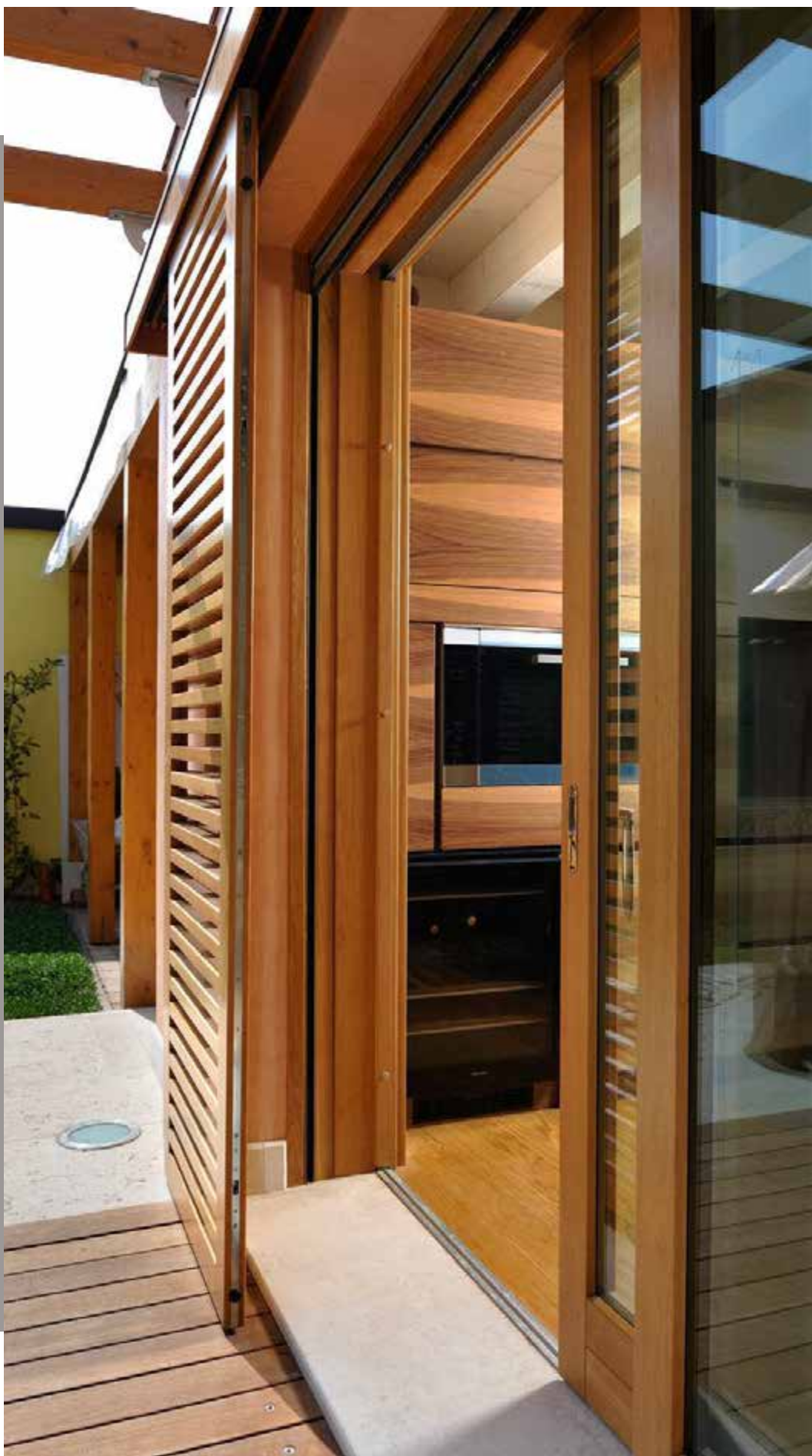
Alzante scorrevole in Rovere e sistema di ombreggiamento esterno a doghe con apertura sincronizzata.
